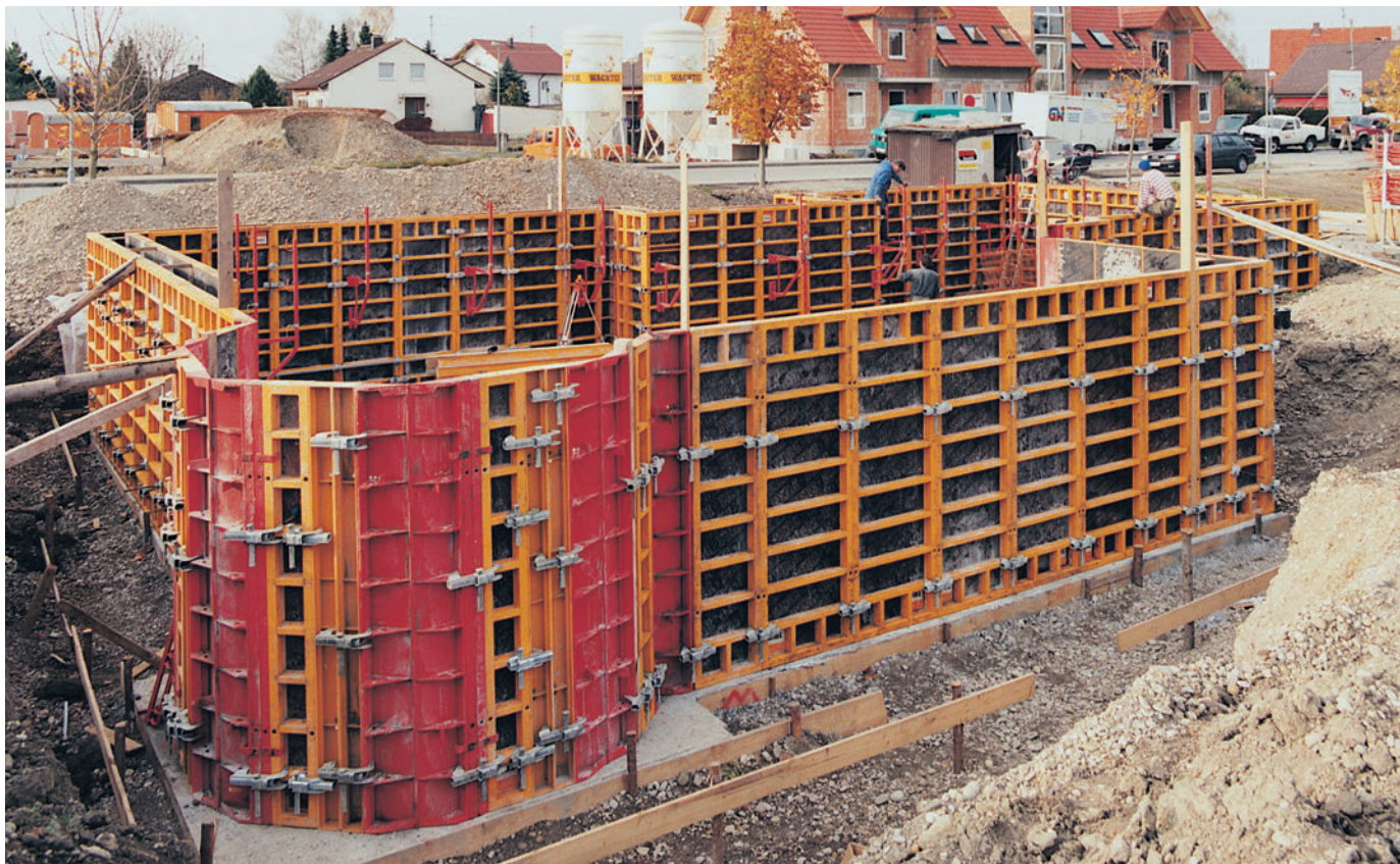
TRIO-L čine paneli sa 4 širine i 2 visine: 270 i 90 cm.
