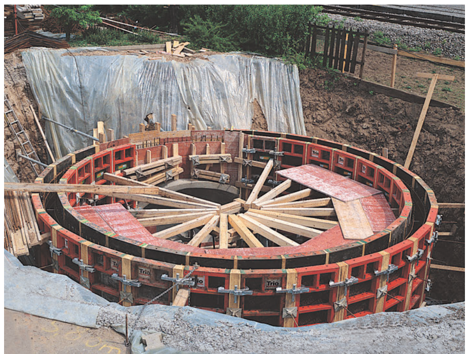
Oplata rezervoara za otpadne vode od TRIO panela TR 270 x 60.
