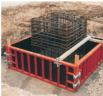
Paneli koji su položeni zbog izrade temelja.
