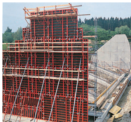
13,20 m visoki zid
