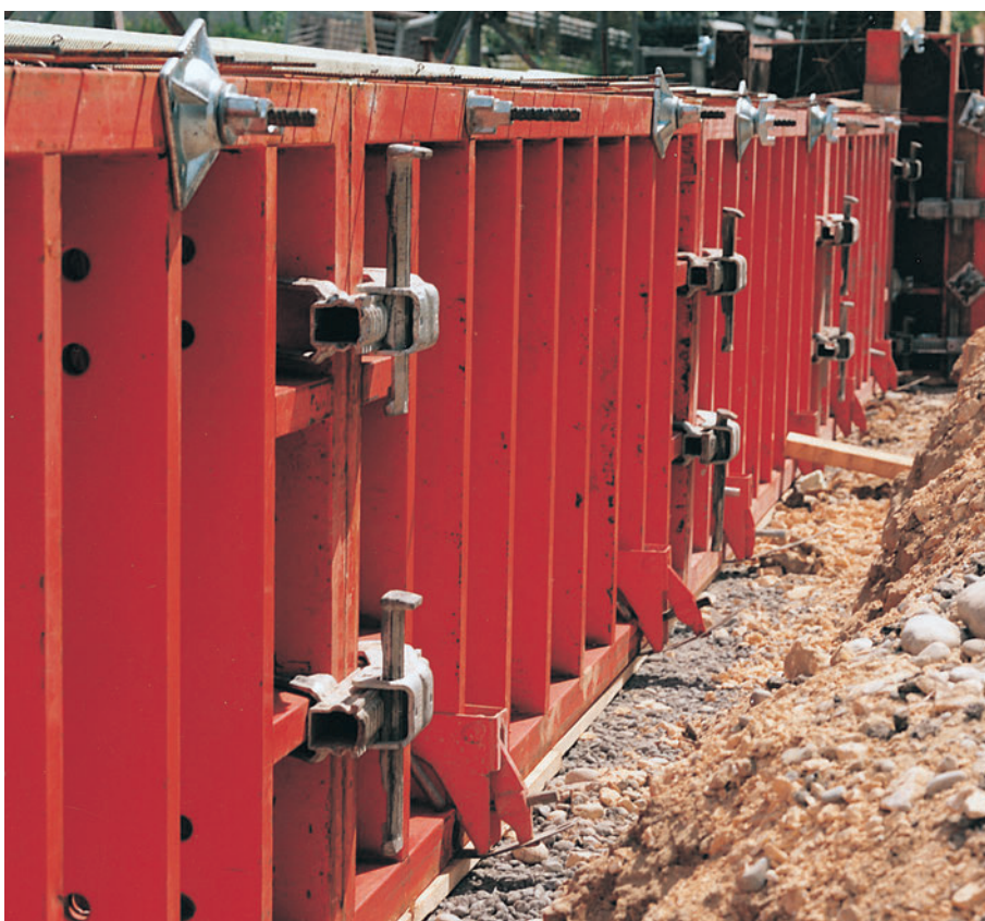
Oplata trakastog temelja fabričke hale učvršćena zatezačem temeljne trake.
