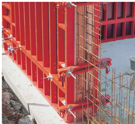
Kod velikog elementa 270 x 240, tj. TRM 72 višenamenskog elementa.
