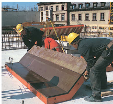
Ugaoni element od 135°, sa oblogom od veliko-površinskog špera, upotrebljen pri gradnji hotela.
