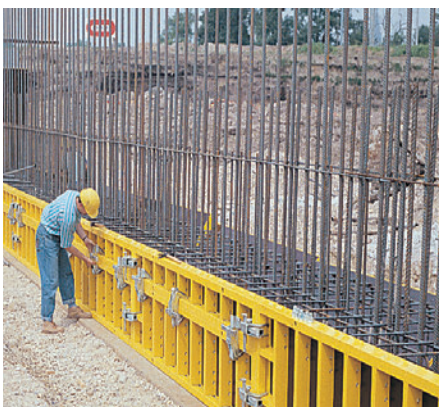
TRIO-L upotrebljen za izradu oplata temelja.
