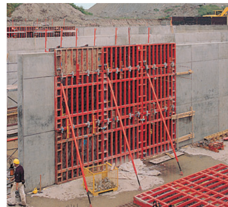
TRIO paneli u položenom stanju i nastavljeni do visine od 6,0 m.
