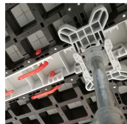
Metoda podparcia wtórnego z użyciem płyt o szer. 15 cm umożliwia wczesne rozdeskowanie, dzięki czemu płyty i łączniki będą gotowe do dalszych zadań.
