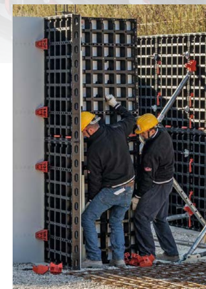
Za pomocą płyt można wykonać słupy o boku od 15 cm do 55 cm w module co 5 cm.
