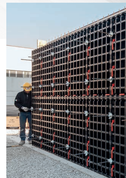
Dzięki DUO można wznosić ściany do wysokości 5,4 m bez użycia dźwigu.
