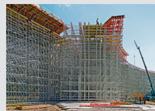
Rusztowania podporowe
