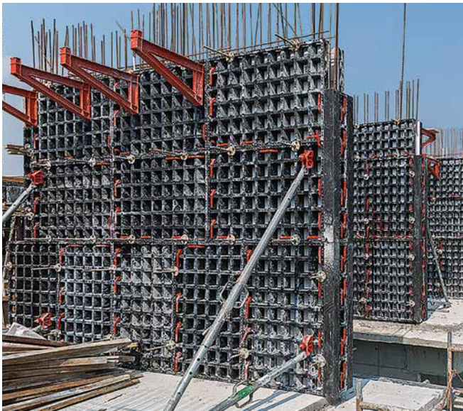
DUOn menestyksellinen käyttö seinämäisiin pilareihin .
