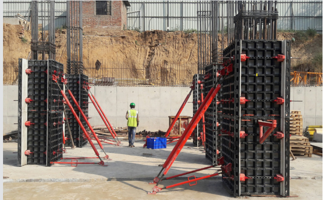
벽체, 기초, 컬럼, 슬라브 등 다양한 구조물에 적용 가능한 다용도 경량 거푸집
