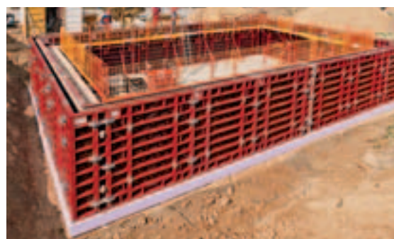
Krótki czas budowy - wysoki stopień bezpieczeństwa. MAXIMO i system bezpieczeństwa PROKIT na pomostach do betonowania. Piwnica domu, Weissenhorn
