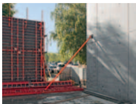
Uporządkowany układ odcisków płyt i ściągów na widocznych powierzchniach ścian. Siedziba Outlet-Center, Metzingen
