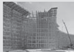
Rusztowania podporowe
