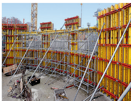
Przykład użycia z deskowaniem VARIO GT 24 Den Arktiske Ring, Zoo w Kopenhadze, Dania
