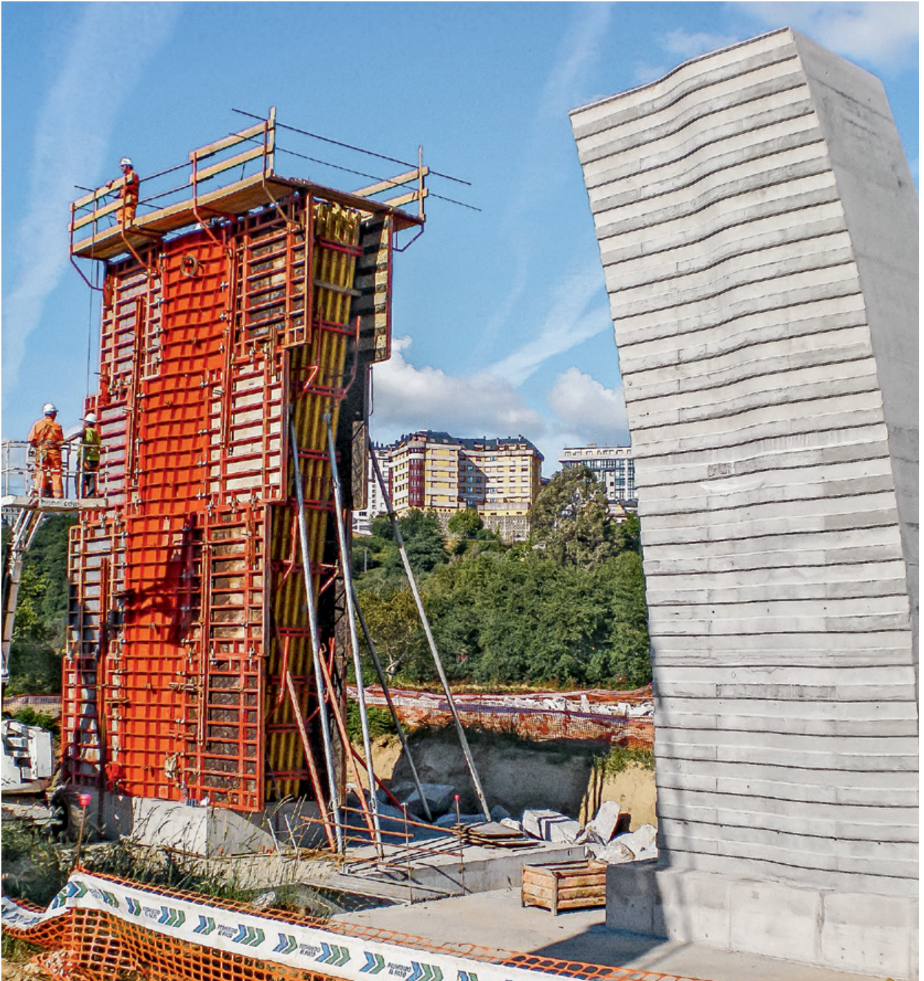
Płyty TRIO Struktur przy budowie filaru mostu: dodatkowo zamontowane listwy drewniane po- zwoliły uzyskać interesującą fakturę betonu.
