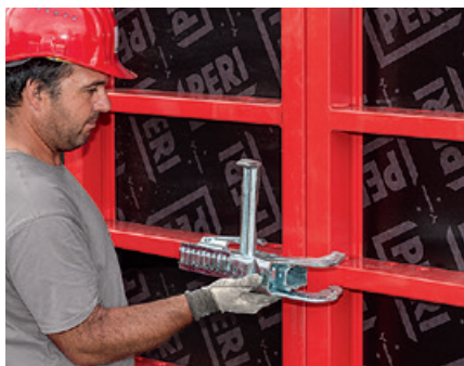
Zamek BFD jest łatwy w obsłudze. Wprawny cieśla może posługiwać się nim jedną ręką.
