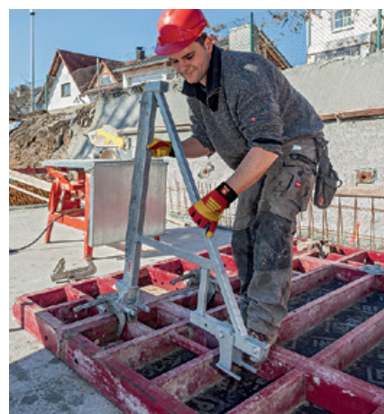
Pomosty robocze montuje się do płyty o analogicznej szerokości. Nie trzeba ich demontować pomiędzy przestawieniami.
