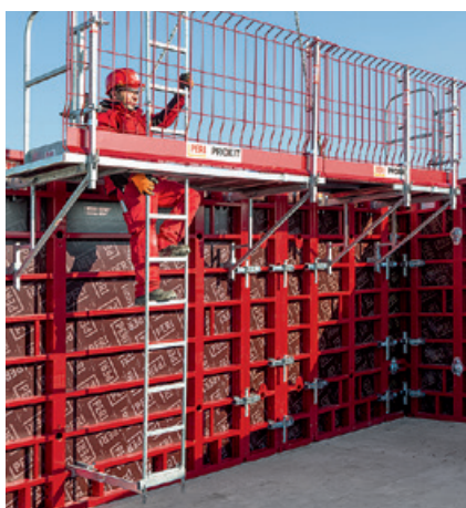
W standardowym zastosowaniu pomosty MXK mogą mieć 2,40 m, 1,20 m lub 0,90 m szerokości.
