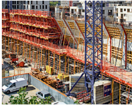
Budynek biurowy, Boulogne-Billancourt, Francja
