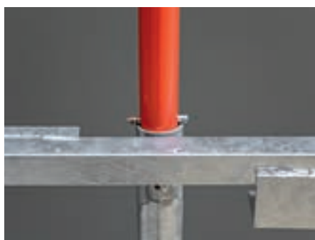
Przedłużacz słupka FB należy po prostu wetknąć w rurę poręczy.
