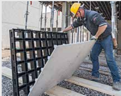
2. Entfernen der beschädigten Schalhaut
