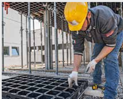
4. Festschrauben der neuen Schalhaut
