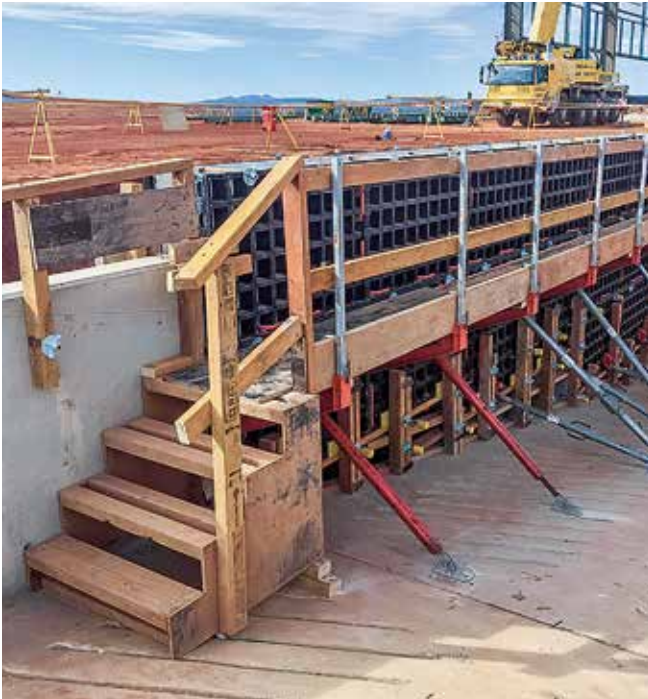
Der Einsatz der DUO ermöglichte eine erhebliche Effizienzsteigerung auf der Baustelle.
