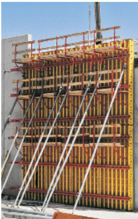
行政機関の構造物の施工に使用された VARIO / バリオ パネル
