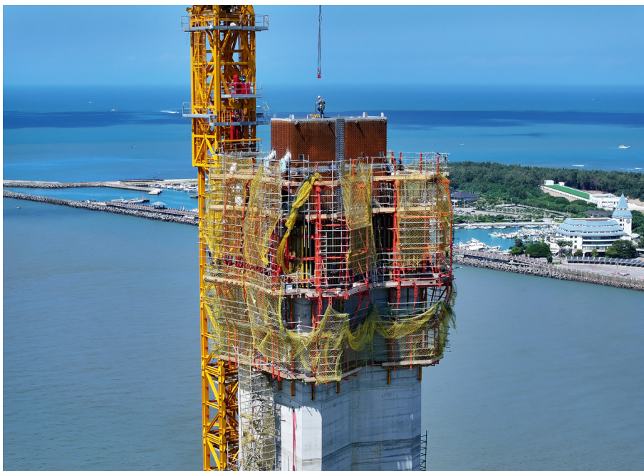
淡江大橋 (Danjiang Bridge Project) 主塔 (U30 ~ 49) ACSでの施工
