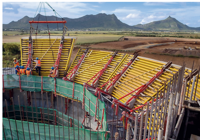
クレーン用吊り上げポイントにより、型枠部材はクレーンでそれぞれの所定の位置に簡単に吊り上げ設置することができた。
