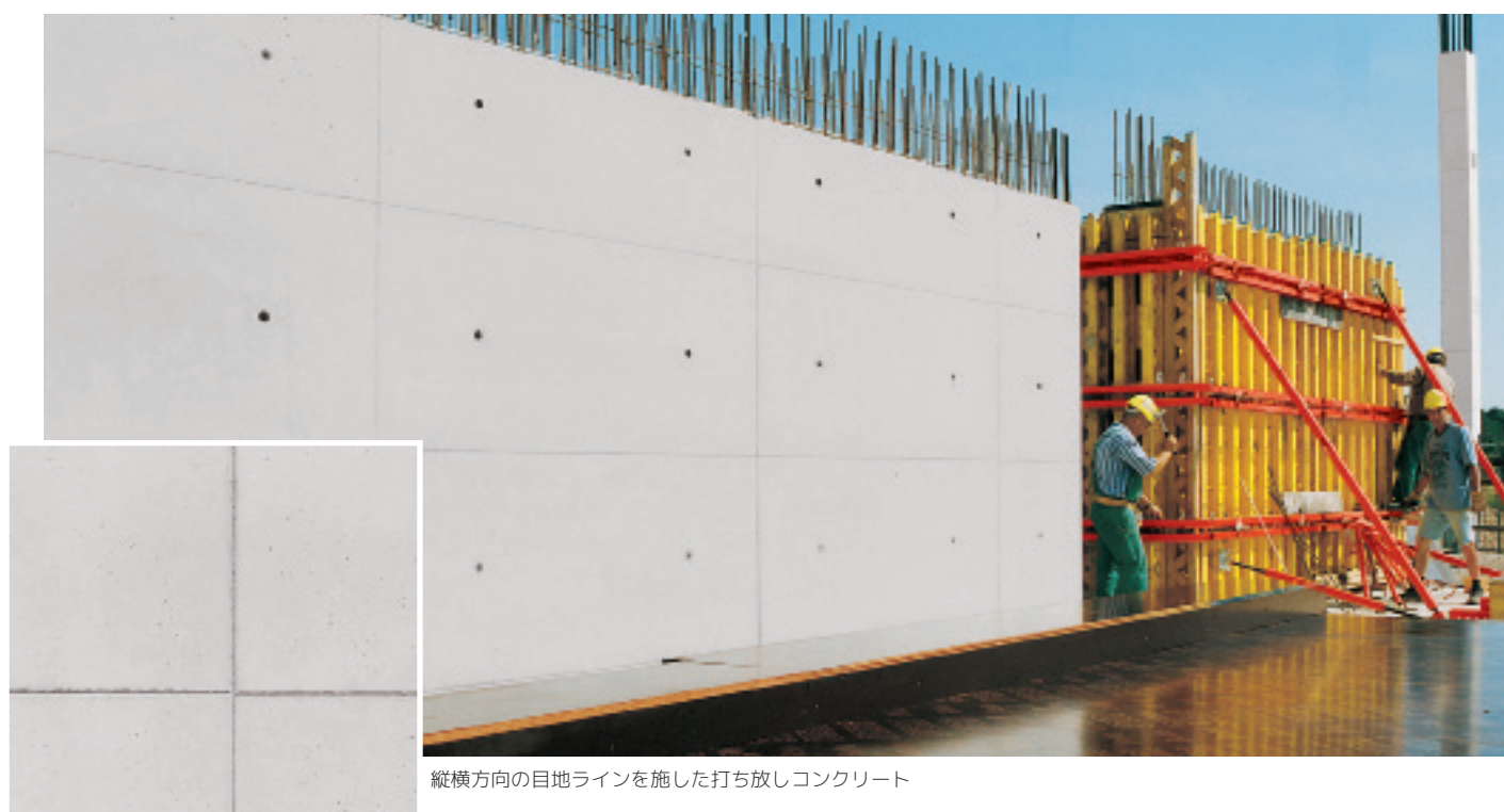
礼拝堂（ドイツ・ノイビーベルク市） 規則的なタイロッドパターン VARIO/パリオ
