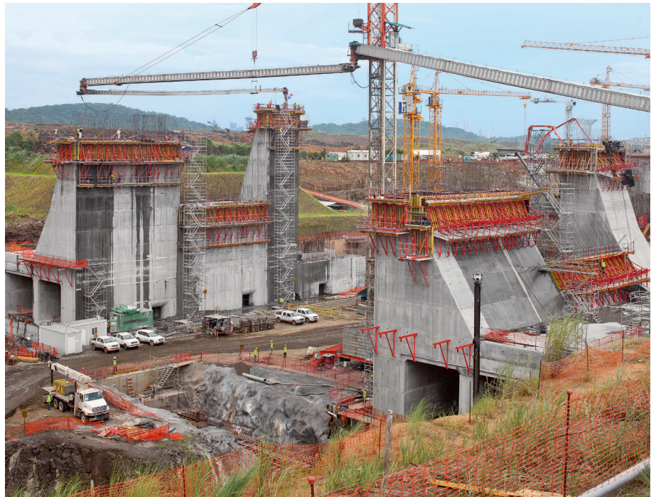
パナマ運河拡張工事（閘門 パナマ
