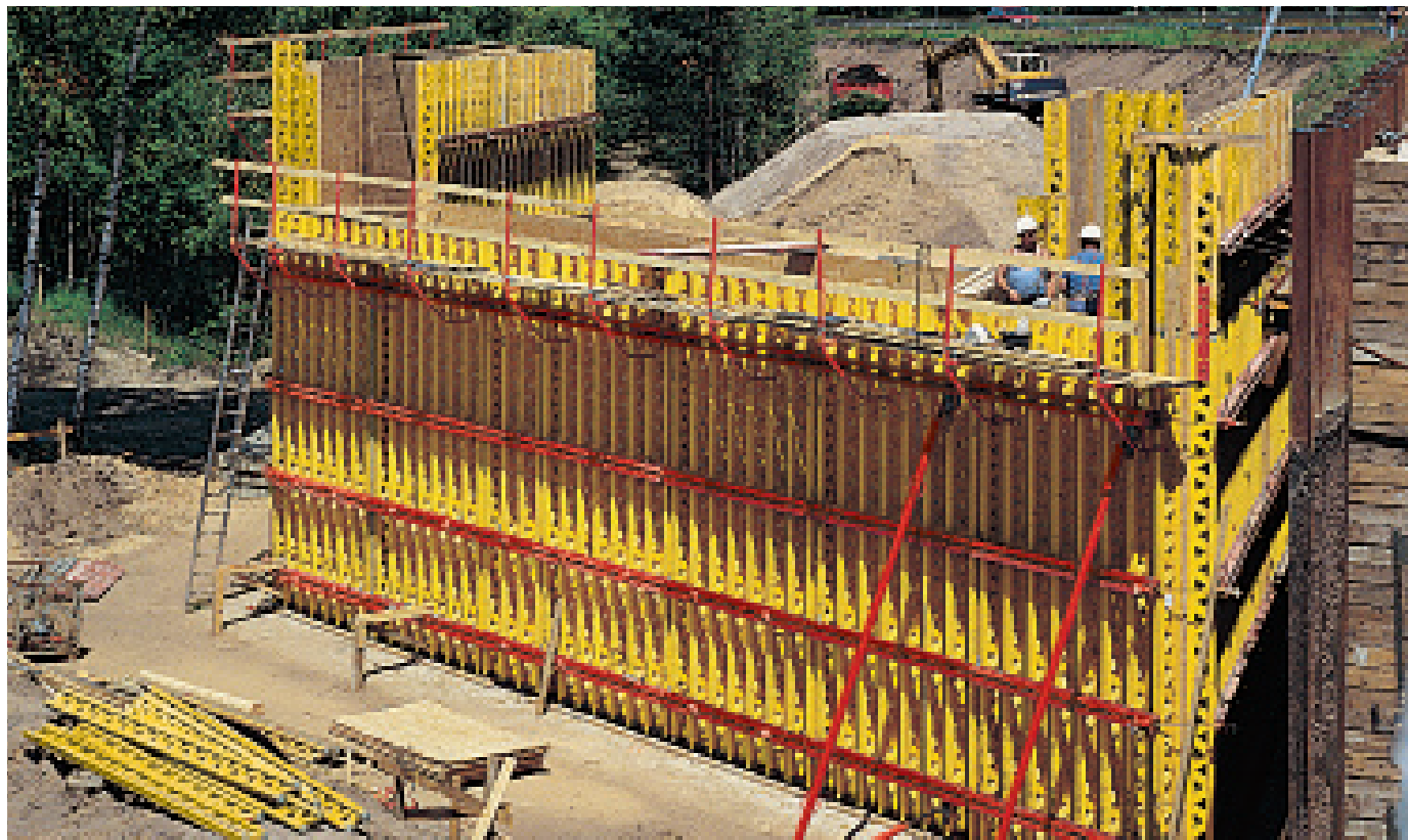
VARIO GT24 標準パネルと現場支給の調整材を使用した橋台
