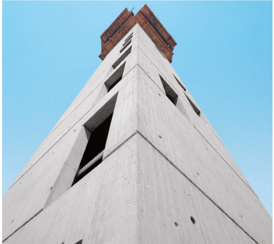
垂直面を本ザネ仕上げで施工した 美しい外観のコンクリート
