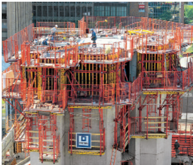
高層ビル建設におけるトラスビーム GT24とクライミ ングシステム CB240の使用例
