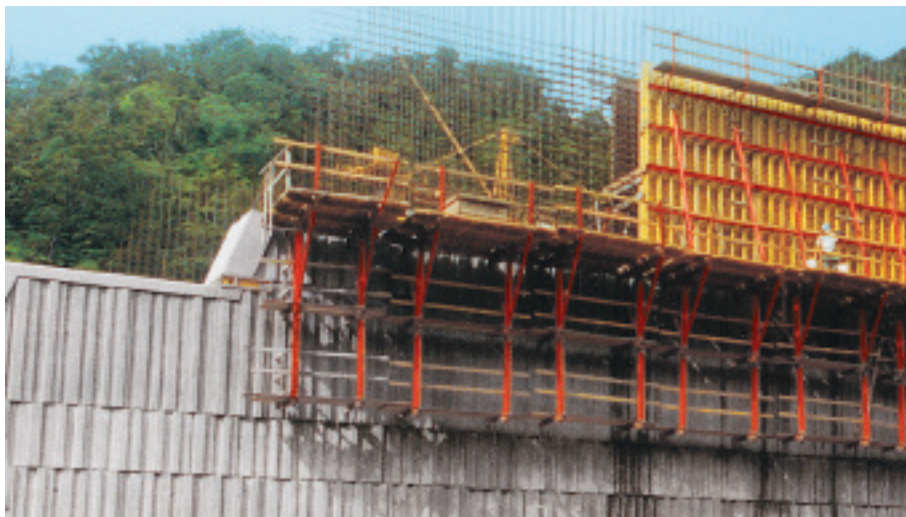
ハワイのトンネル入口 KGF240クライミングシステムとGT24で施工
