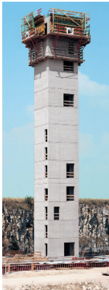
打ち放しコンクリートで施 工した43.50mの工場塔
