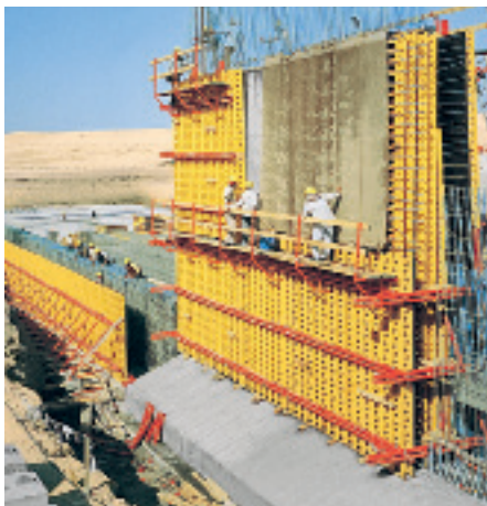
沈殿タンク傾斜壁の施工に使用された VARIO GT24 / バリオ GT24
