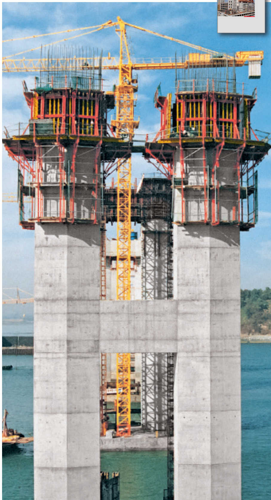
三角型ブラケットのクライミングシステム CB240は、型枠の両側で作業をすることが可能です
