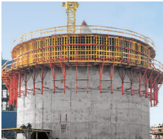
円形タンク建設におけるVARIO GT24 / パリオ GT24 の使用例 トラスビームとスチールウェールの間に木製ウェッジ を用いて円形を形成
