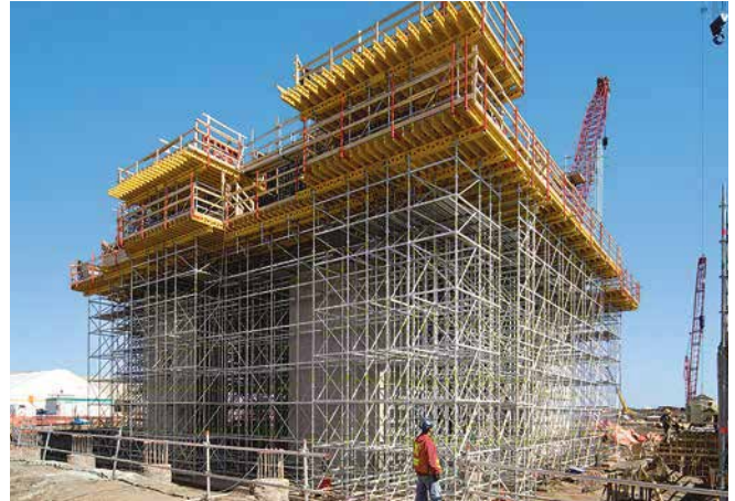
Con PERI UP Rosett y MULTIFLEX se descargaban con toda seguridad los esfuerzos de partes macizas a una altura de entre 10 y 12 metros al suelo.
