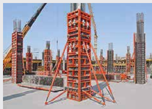
Encofrados para pilares y columnas circulares
