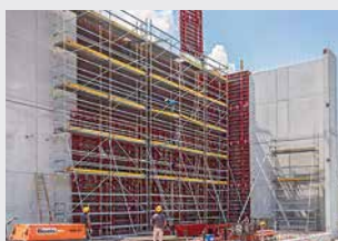
Andamios de trabajo para la construcción
