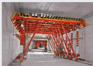
Encofrados para túneles
