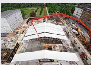
Andamios de protección
