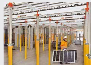
Encofrados para losas
