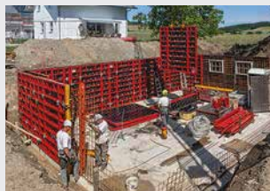
Encofrados para muros
