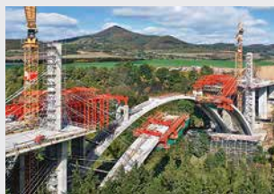
Encofrados para puentes
