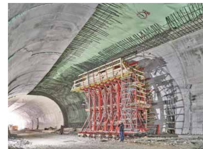
Razširitev opaža na dvopasovni prerez tunela.
