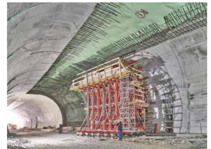
Proširenje oplata na dvotračni presjek tunela
