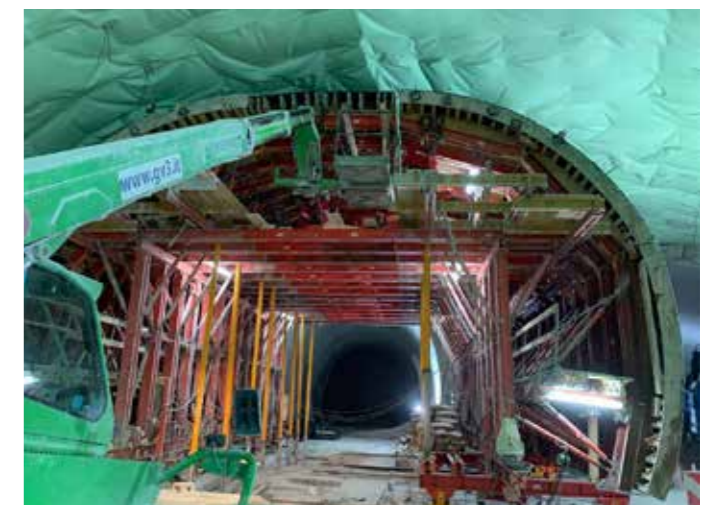
Proširenje oplata na dvotračni presjek tunela
