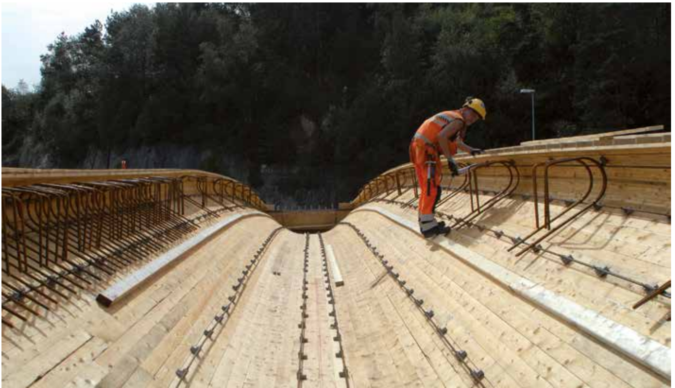
Bilde: Vassteigen bro, Ringvei vest, Bergen. Arbeidstegninger og profiler er levert av PERI
