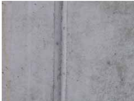
Kontrollert riss med Cetflex CV
